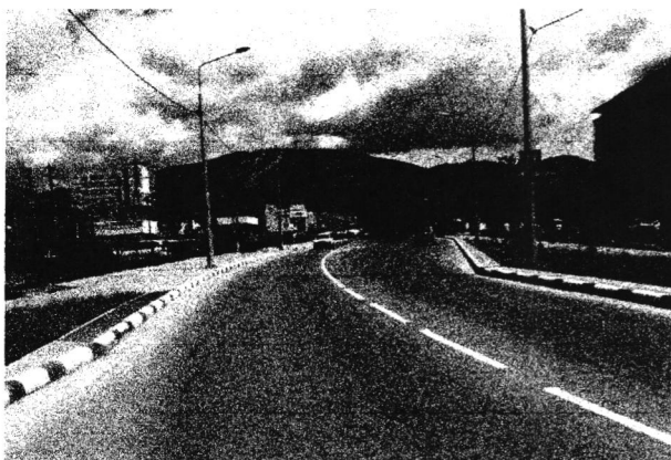
Реконструкция дорожного покрытия
