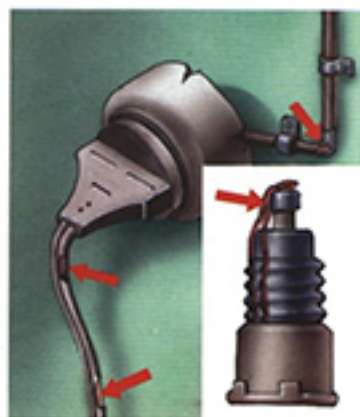
Неисправность электропроводки Пользование самодельными предохранителями
