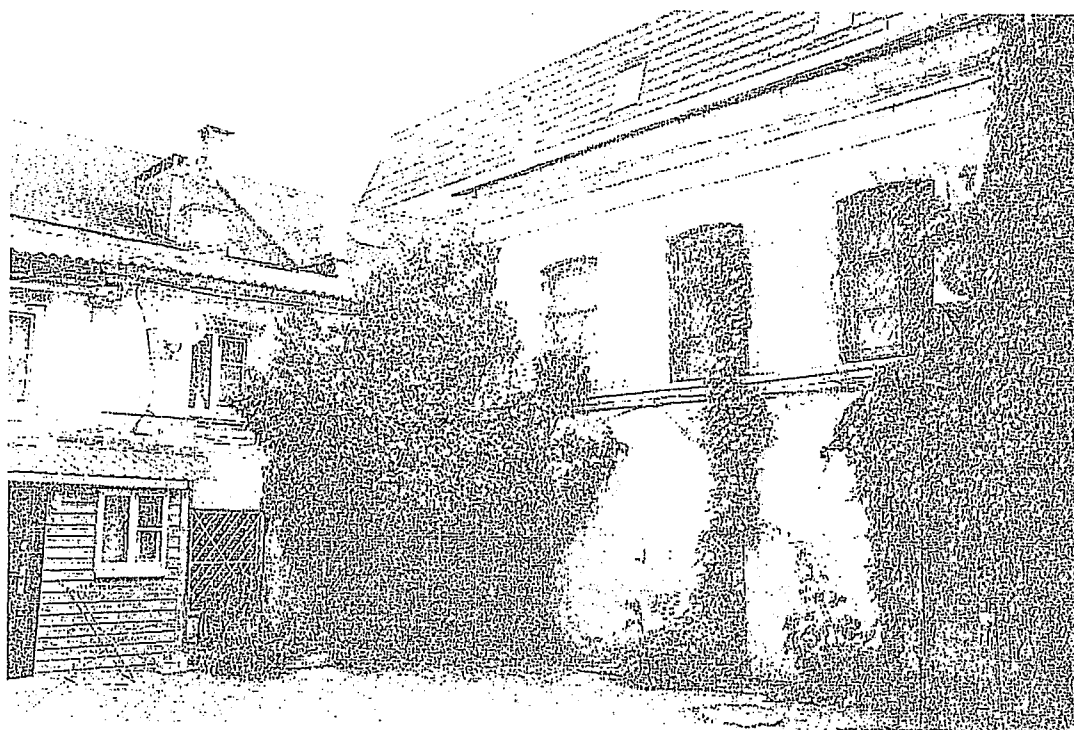
«Усадьба Матвеева В.С., до 1883г.» ул. Свердлова, 15 /ул. Советской Милиции, 6, г. Астрахань. Западный дворовый фасад лит. «Б» Фото Севастьяновой А.В. октябрь 2018г.
