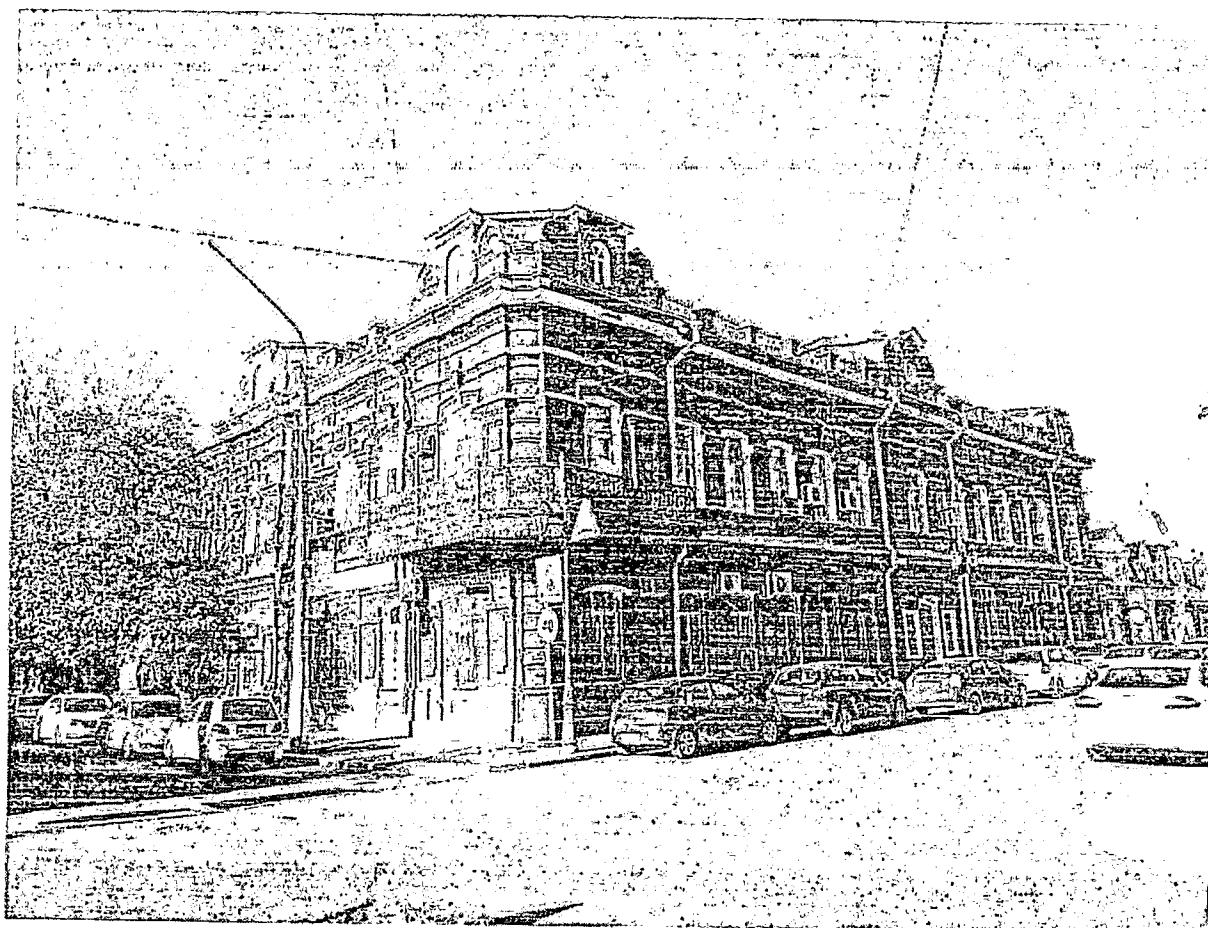
Фасады лпт. «А» по ул.Никольская,10.ул.Ульяновых,14, фото Чагиной И.В., 2018г.
